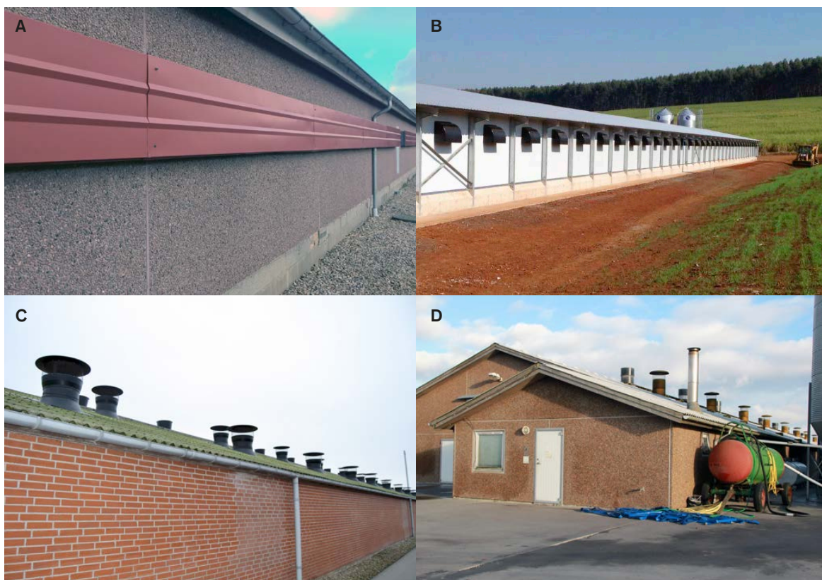
Figur 3. Slagtekyllingehuse med forskellige ventilationssystemer: A og B har horisontal ventilation, dvs. at luft suges ind gennem ventilation-ventiler i væggen (100-200 stk. ventiler). Ventilene er dækket af lyssikringsplader eller "hætter". C og D har vertikal ventilation, hvor luft tages ind gennem skorstene i taget (høje eller lave skorstene).
