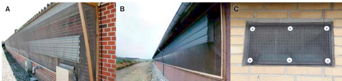
Figur 1. Insektværn – forskellige varianter af fæstemekanismer, A og B – en af de tidlige varianter hvor nettet er sat på trærammer og C – Phifernet er spændt fast direkte på ventilen.
