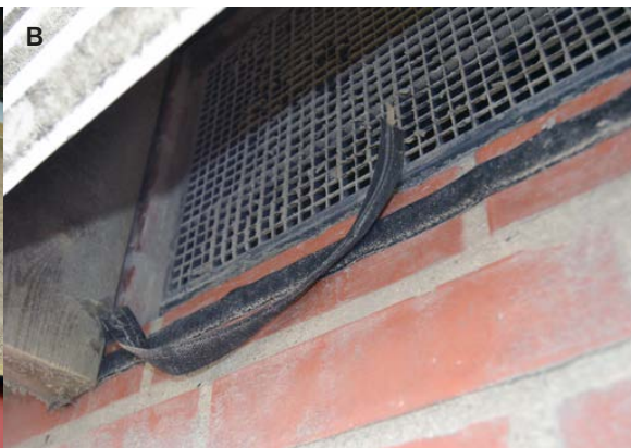
Figur 8. Velcro bør limes fast til lysikringspladen (A= prototype 1) og fra væggen (B= prototype 2) på ny da limet har "sluppet".
