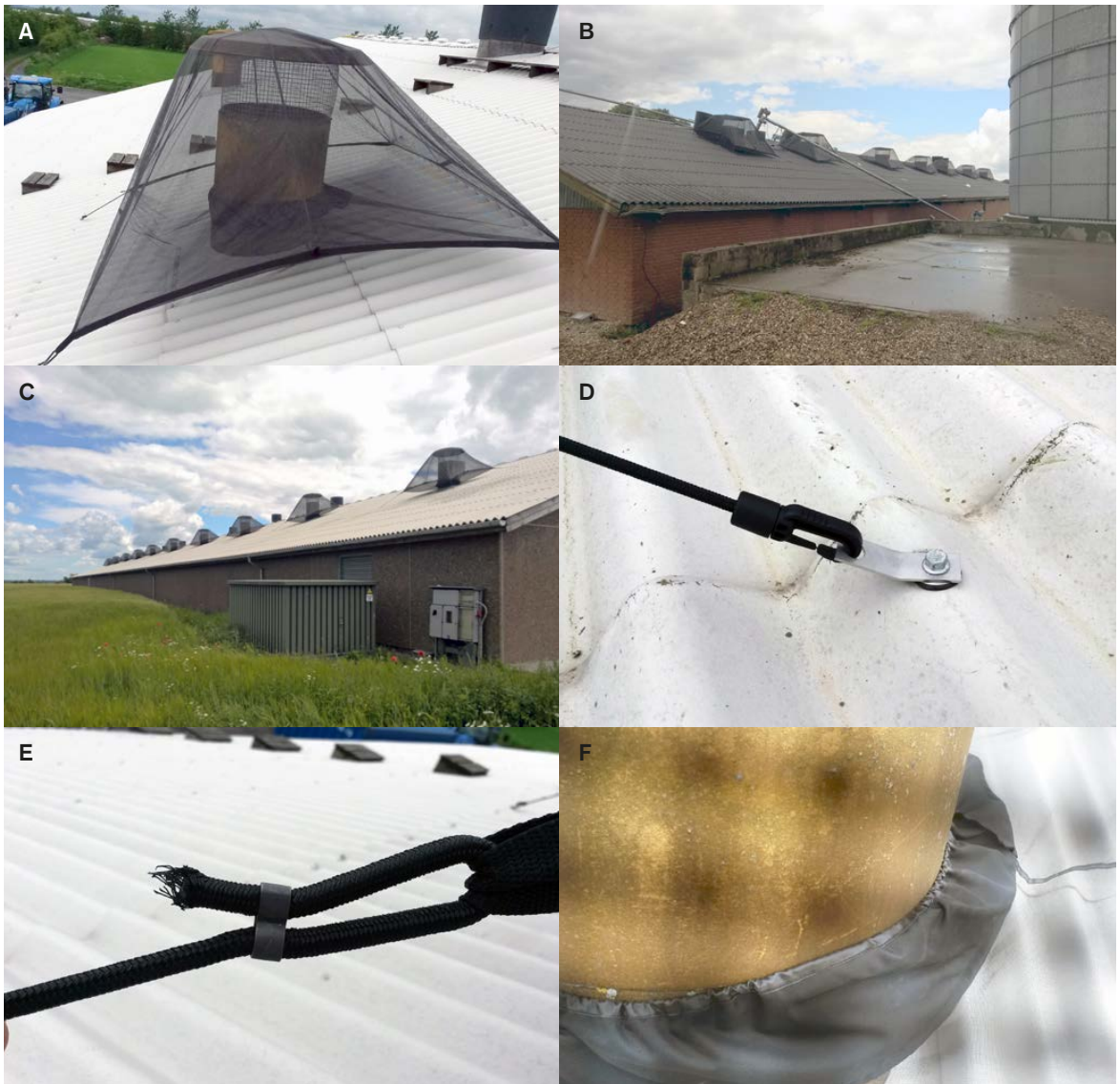
Figur 6. Billeder af prototype 4 fastspændt på slagtekyllinge-hus med DACS-skorstene (A og C) og på Turbovent-skorstene (B) med 4 elastiske snore fastspændt til taget (D og E). I bunden af "skorstens-teltet" omslutes skorstenen af en elastisk muffe (der dermed kan passe skorstene med forskellige diameter (F).
