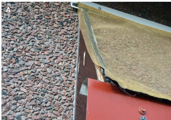
Figur 8. Velcro bør limes fast til lysikringspladen (A= prototype 1) og fra væggen (B= prototype 2) på ny da limet har "sluppet".
